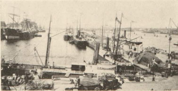
DIE KVÆSTHUS- BRÜCKE
