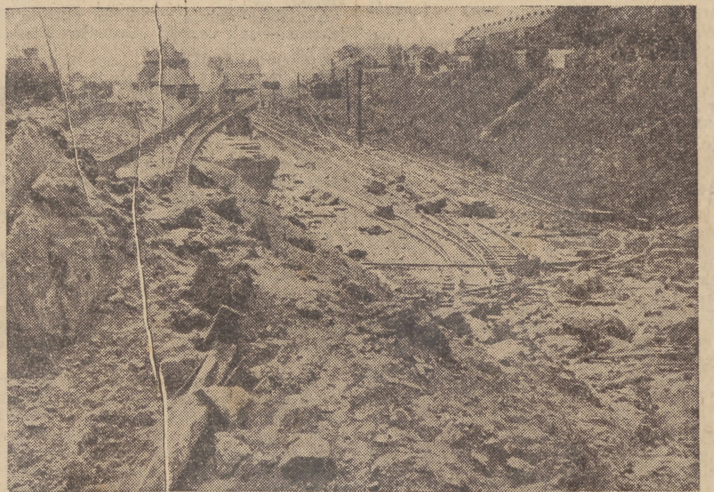
Obraz zniszczenia w Belgji.
