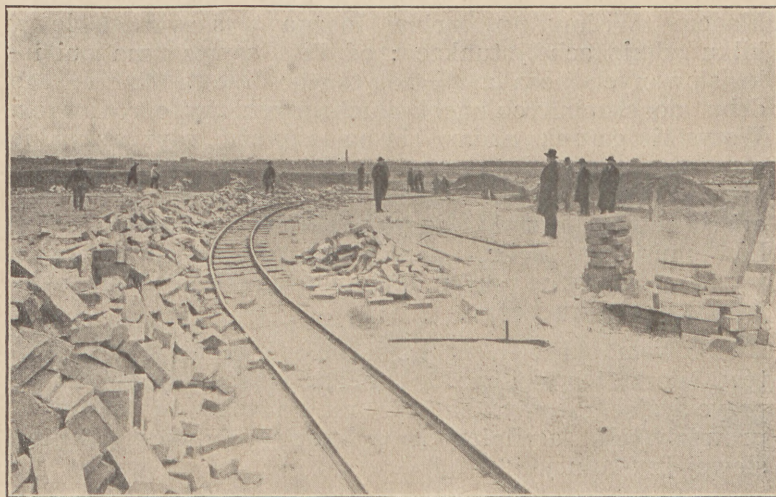
Przy budowie Głównej Aleji na terenach zachodnich P. W. K.
