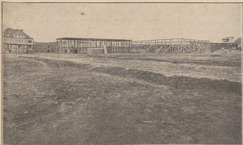
Pawilony przy bramie Głównej na terenach zachodnich P.W.K.
