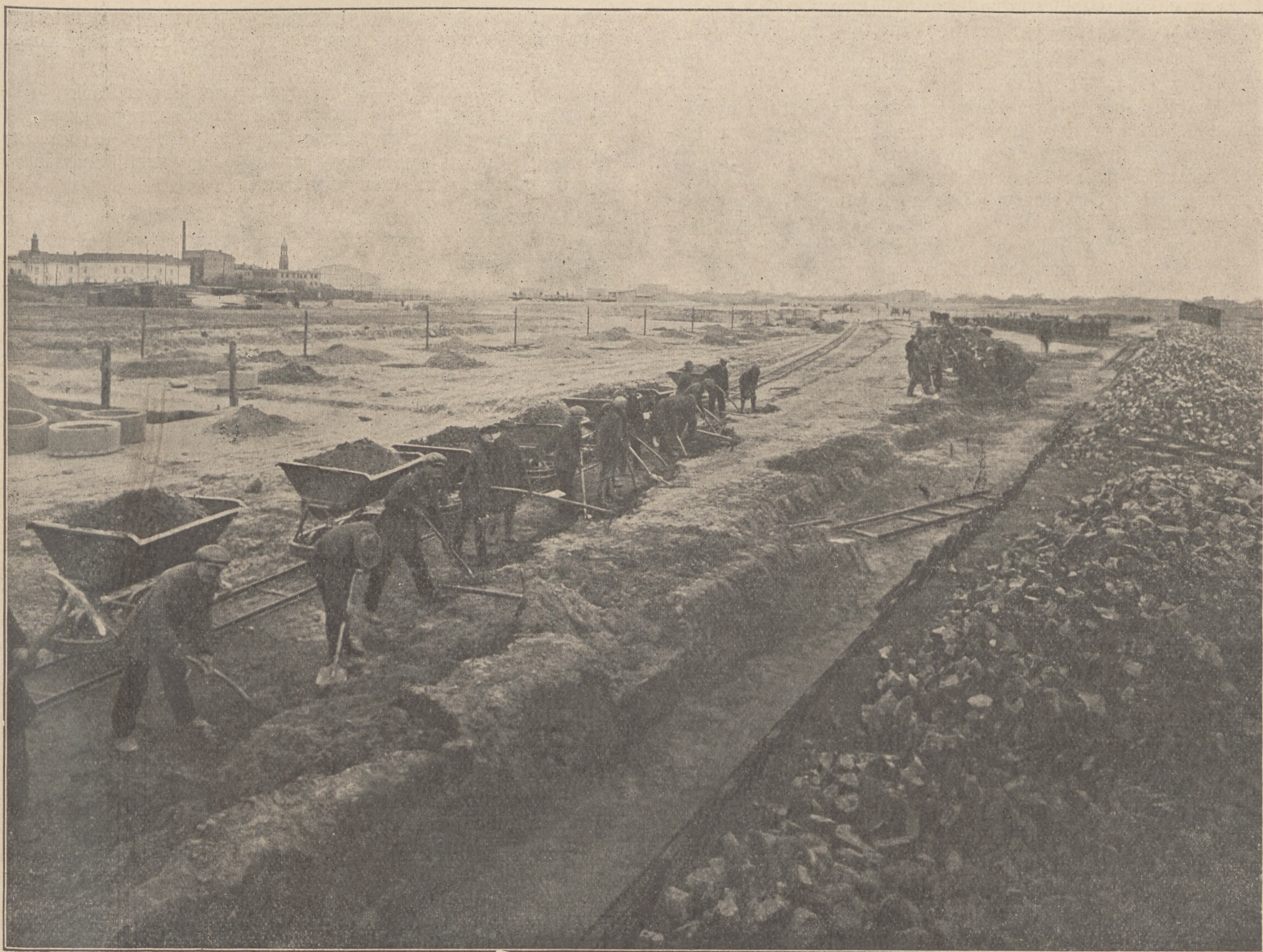
Budowa Głównej Aleji na terenach zachodnich P. W. K.
