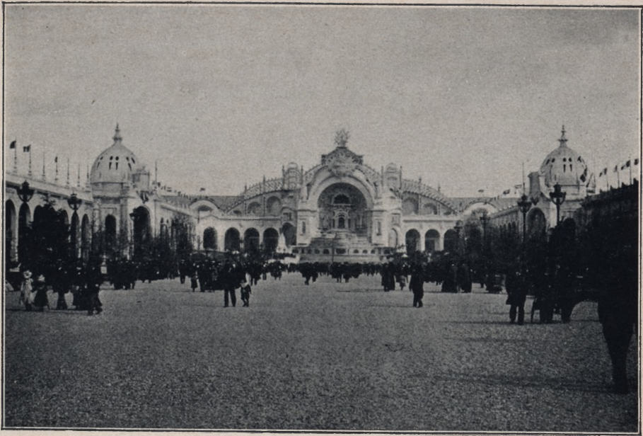
Palais de l'Électricité et Château d'Eau.
