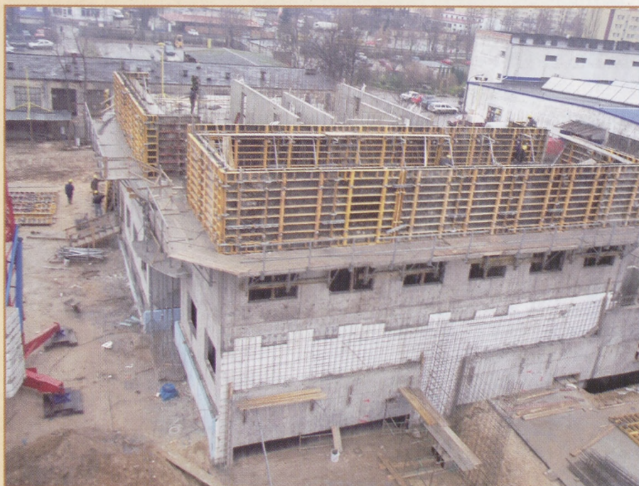
Początek budowy akademika – jesień 2002...
